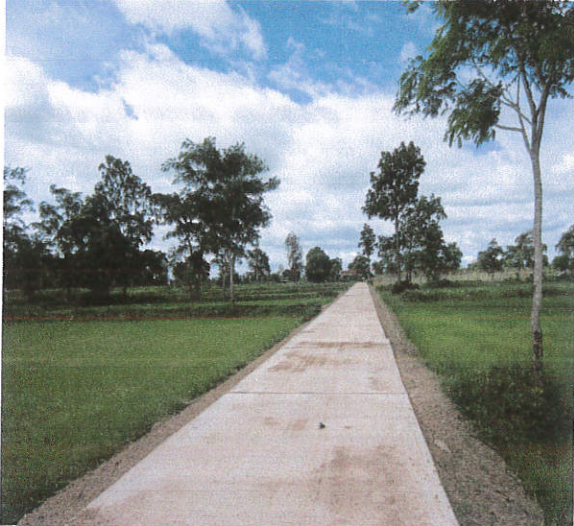
โครงการก่อสร้างถนนคอนกรีตเสริมเหล็ก บ้านนากระแซง หมู่ที่ 13 ซอยสร้างคำ
