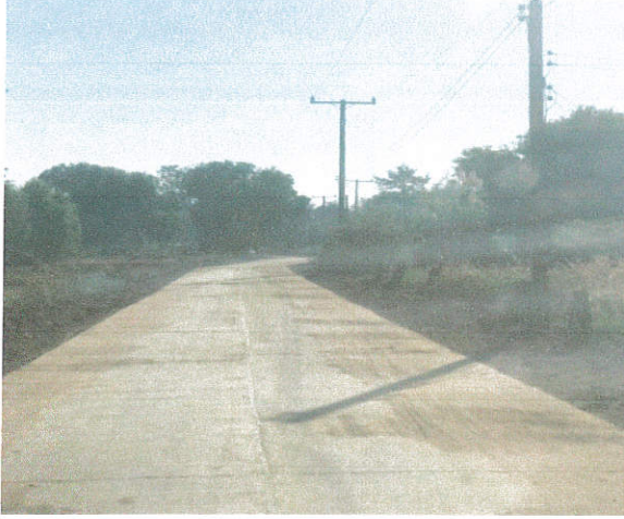
โครงการก่อสร้างถนนคอนกรีตเสริมเหล็ก บ้านหม้อทอง หมู่ที่ 6 ซอยบ้านหม้อทอง-บ้านหนองแต้
