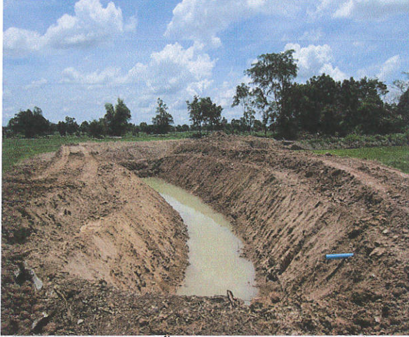
โครงการก่อสร้างรางระบายน้ำ คสล. (รางยู) บ้านหนองแต้ หมู่ที่ 5 ซอยทิศใต้กองทุน
