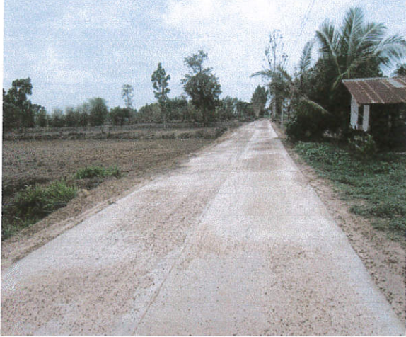
โครงการก่อสร้างถนนคอนกรีตเสริมเหล็ก บ้านโนนสว่าง หมู่ที่ 4 ต.นากระแซง เชื่อมต่อกับบ้านสี่แยกโนนทอง หมู่ที่ 9 ต.นาเจริญ
