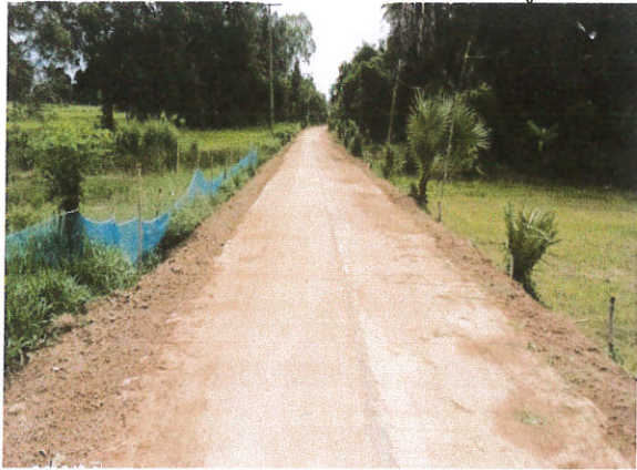
โครงการก่อสร้างถนนคอนกรีตเสริมเหล็ก บ้านคำประเสริฐ หมู่ที่ 12 ซอยบ้านผู้ใหญ่บ้าน
