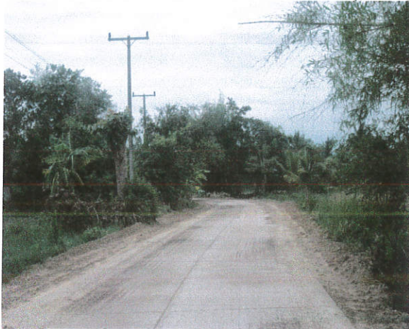
โครงการก่อสร้างถนนคอนกรีตเสริมเหล็กบ้านนากระแซง หมู่ที่ 2 ซอยท้องหาด
